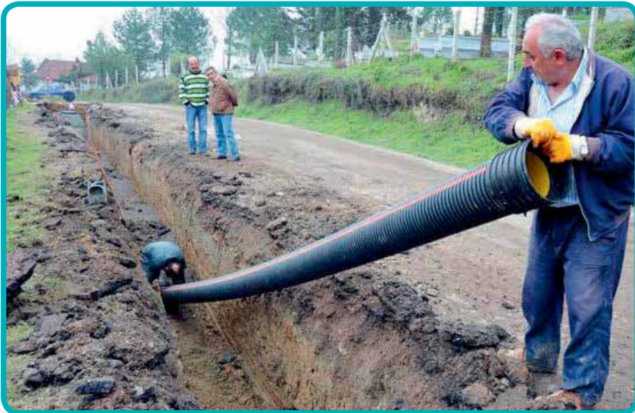
Yağmur suyu kanalı çalışmaları
