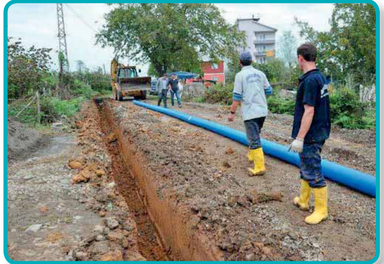
İçme suyu şebekesi çalışmaları
